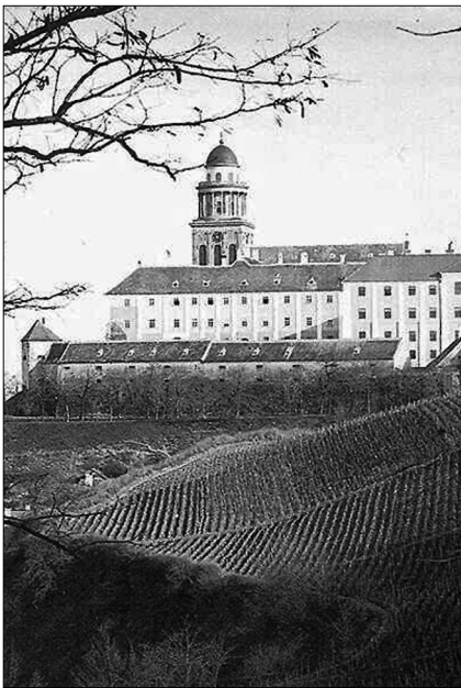
A pannonhalmi bencés apátság
