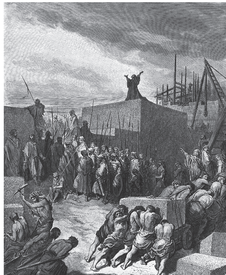
A templom újjáépítése
